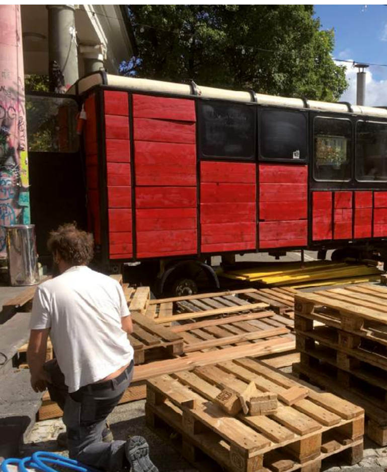
Ein Podest für die Buvette wird gebaut.
